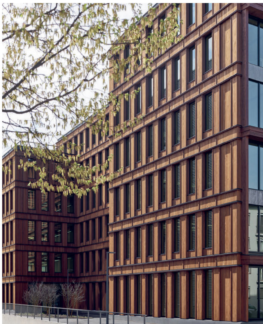
Das «Clime» auf dem Grosspeter-Areal in Basel – ein mehrstöckiges, repräsentatives Bürogebäude in Holzbauweise mit modernstem Innenausbau und Infrastruktur.
