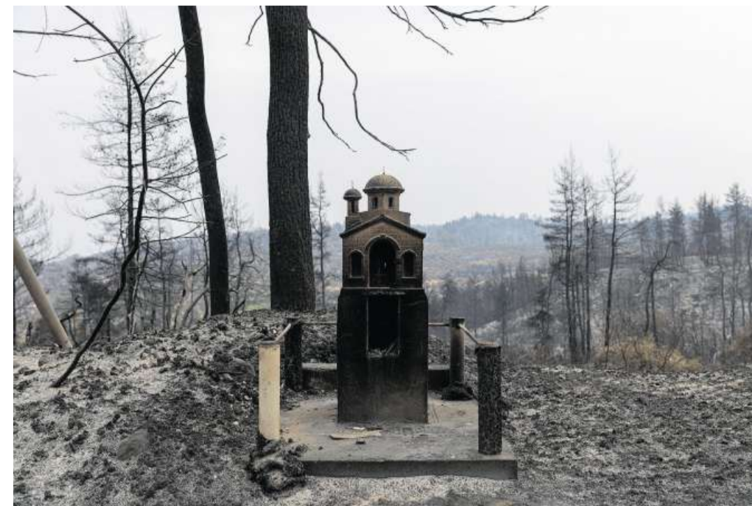
Eine ausgebrannte Kapelle am Strassenrand bei Pefki.
